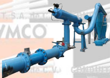
Redes de Agua Potable
